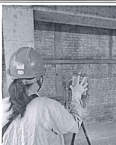
2023.9.6 沸腾炉煤尘检测
