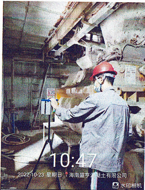
搅拌机粉尘检测 2022.10.23
