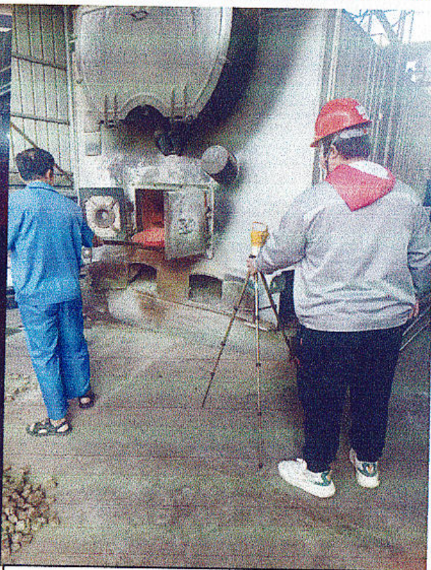
锅炉 粉尘检测 2022.12.13
